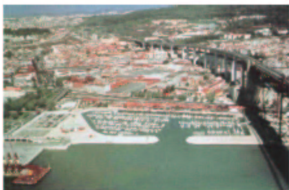
Puerto de Lisboa, vista aérea (Archivo Alcino Soutinho)
