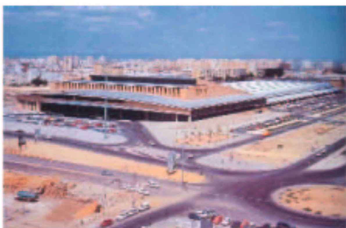
Nueva Estación de Ferrocarriles de Santa Justa, Sevilla (fuente: Architécti n.10)
